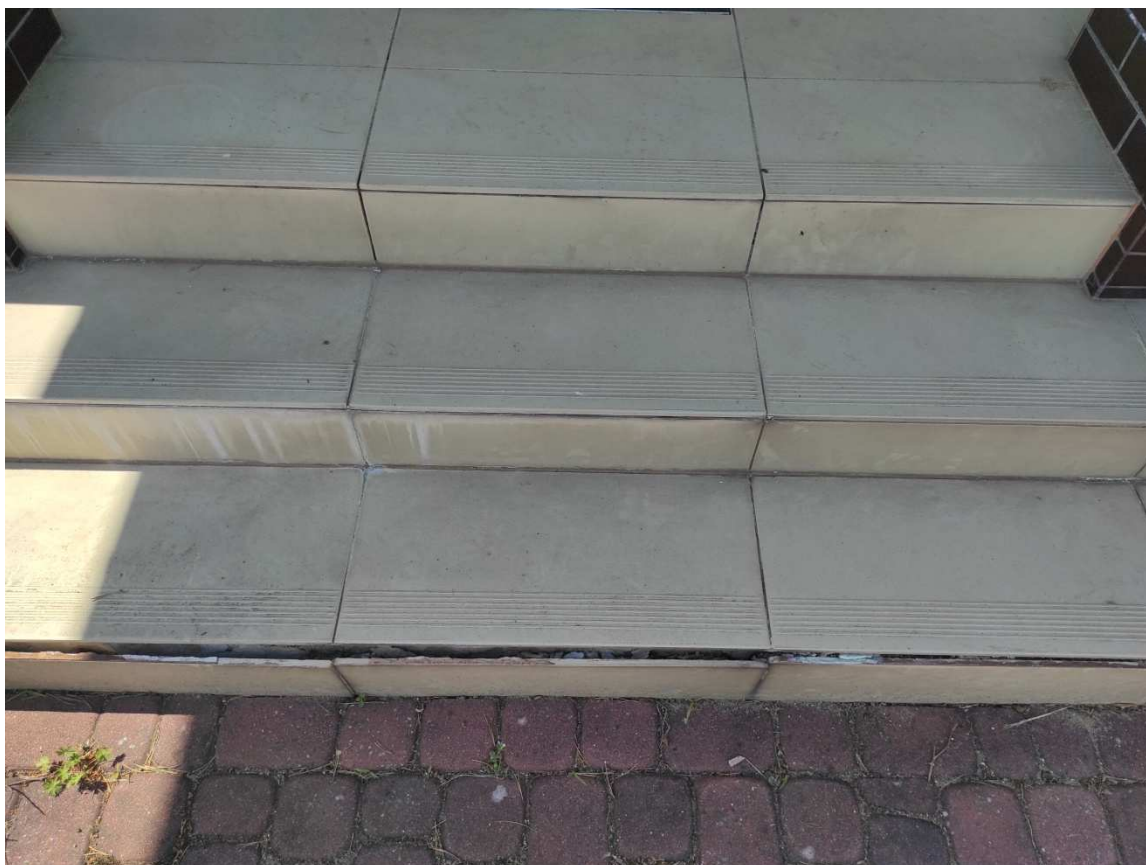
Rys. 1. uszkodzenia okładziny schodów wejścia głównego
