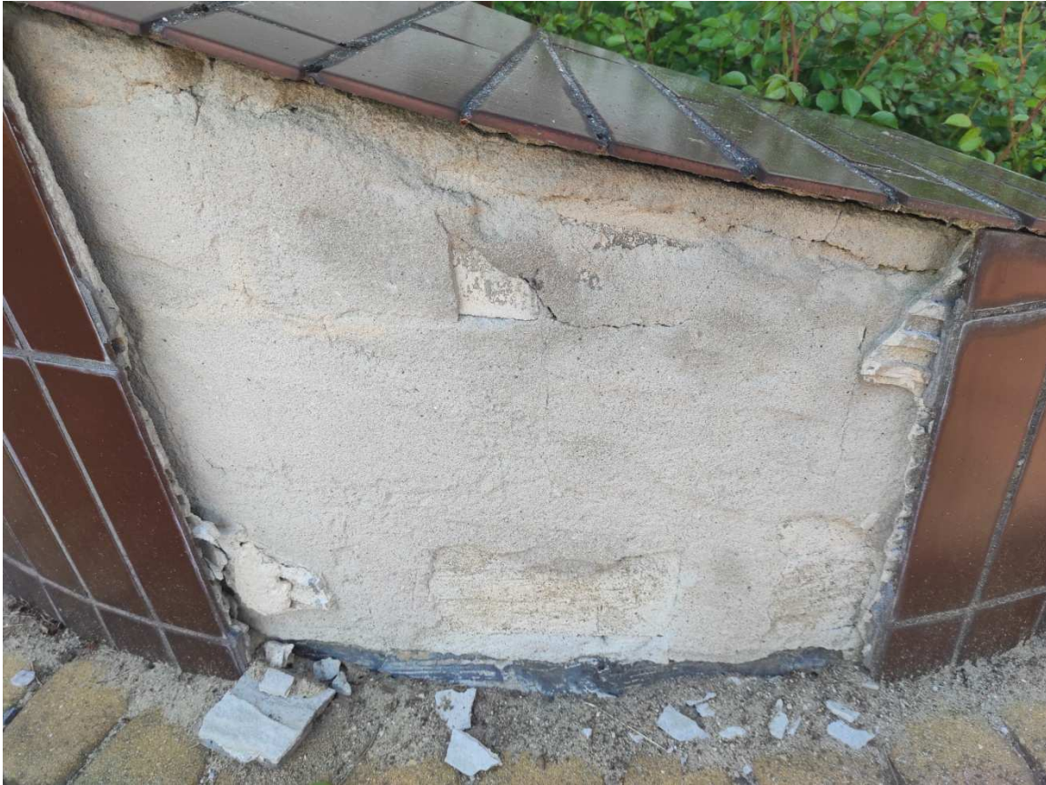
Rys. 2. uszkodzenia murków przy schodach wejścia głównego
